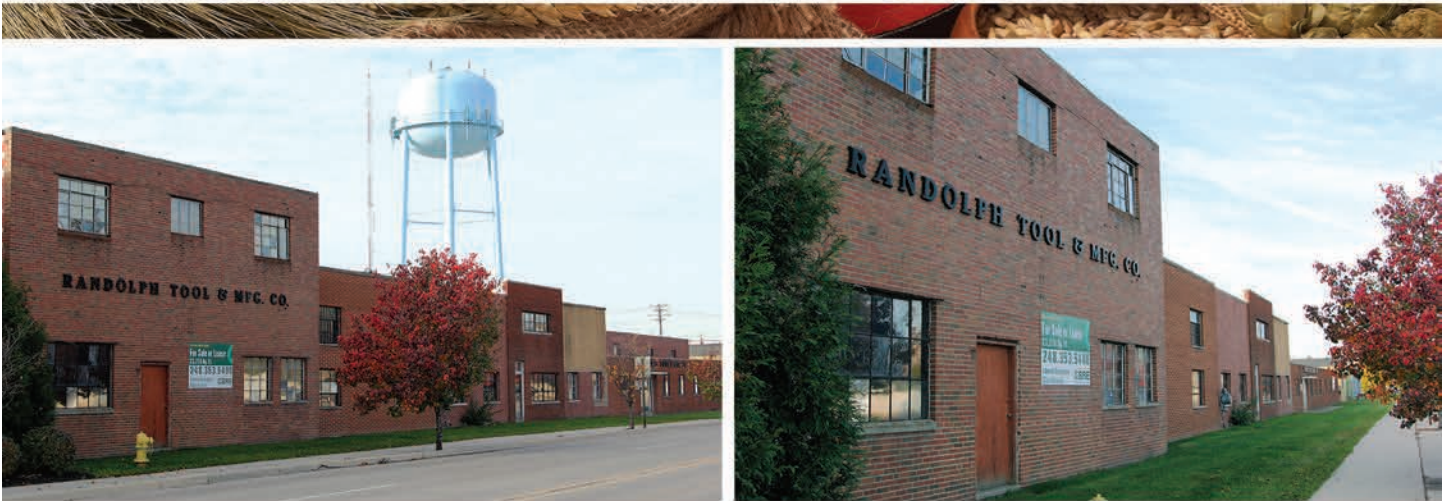
Actual Property Front View
